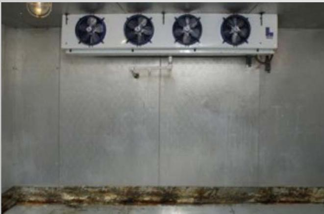
塗裝前：牆壁、地板和底部已嚴重生鏽、腐蝕及遭受污染。衛生部官員要求“修復”，否則將重罰。
