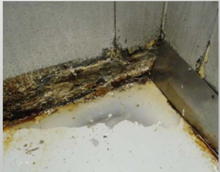
右圖：氣體和副產品所產生的典型腐蝕和腐爛從損壞的貨物中排放出來。金屬罐等活性物質由於長時間暴露而遭到破壞。
