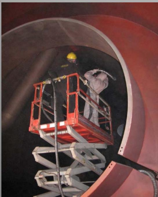
· 成果：有了無縫、整體的耐磨保護後，鋼製儲存桶槽將獲得所需的防腐蝕保護。業者將獲得多年的免維護運行，且避免了高額的更換成本。
